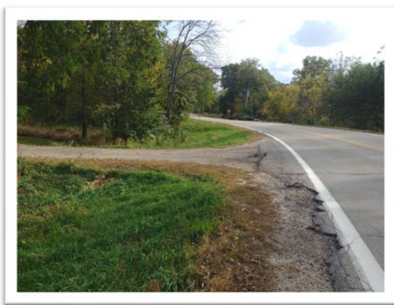
CSAH 28 – Existing Pavement Deterioration
